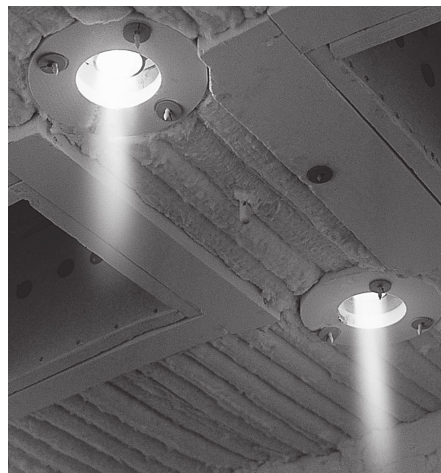
Термическая печь с горелками BIC
